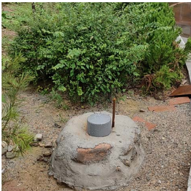
图 4-3 地下水监控井照片（预处理车间附近）
