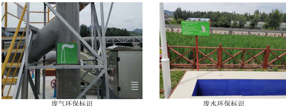
图 4-2 环保标志牌安装照片
